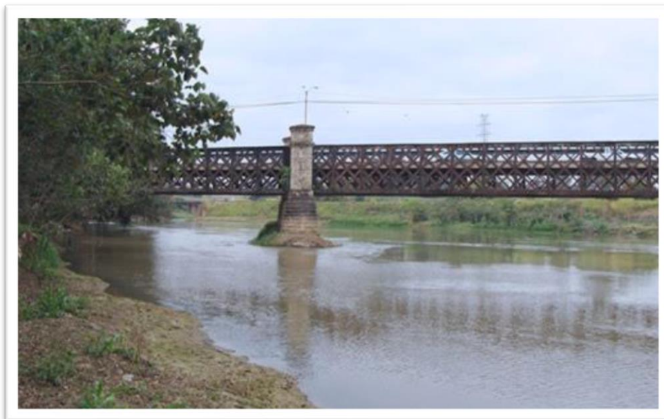
Figura 10 - Pontilhão de Ferro
