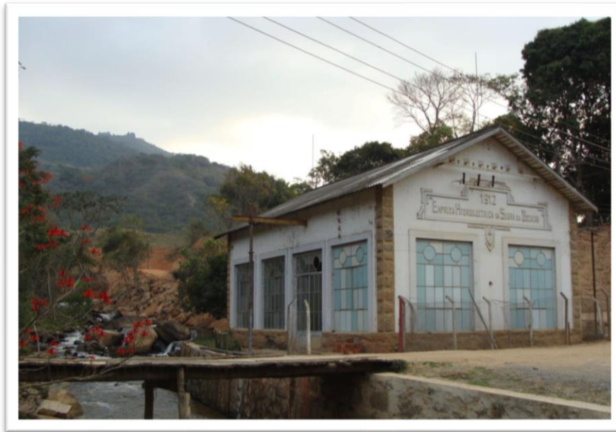
Figura 12 - Represa da Usina Hidrelétrica da Serra da Bocaina
