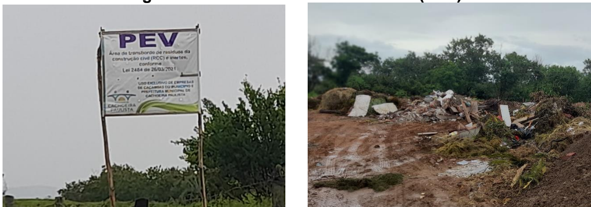
Figura 14 – Aterro Provisório de RCC (PEV)
