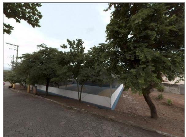
FIGURA 39 – QUADRA COBERTA DO EMBAU FONTE: ACERVO DO AUTOR, 2023
