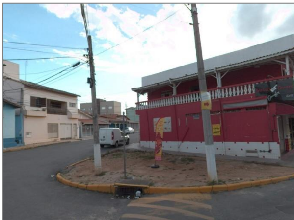
FIGURA 244 - BOCA DE LOBO RUA CONSELHEIRO RODRIGUES ALVES FONTE: GEOPIXEL 2023
