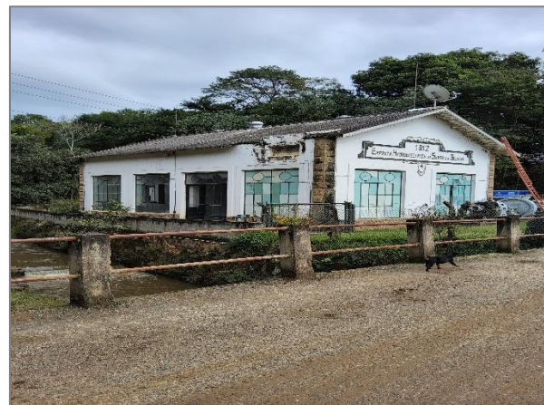
FIGURA 216 – USINA HIDROELÉTRICA FONTE: ACERVO DO AUTOR, 2023
