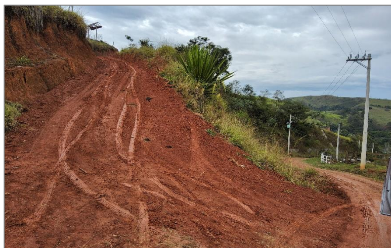
FIGURA 248 – VIA SEM PAVIMENTAÇÃO BAIRRO DA BOCAINA FONTE: ACERVO DO AUTOR, 2023
