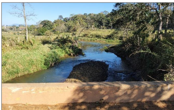
FIGURA 241 - PONTE PERTO DA RODOVIA CRISTIANO ALVES DA COSTA FONTE: ACERVO DO AUTOR, 2023
