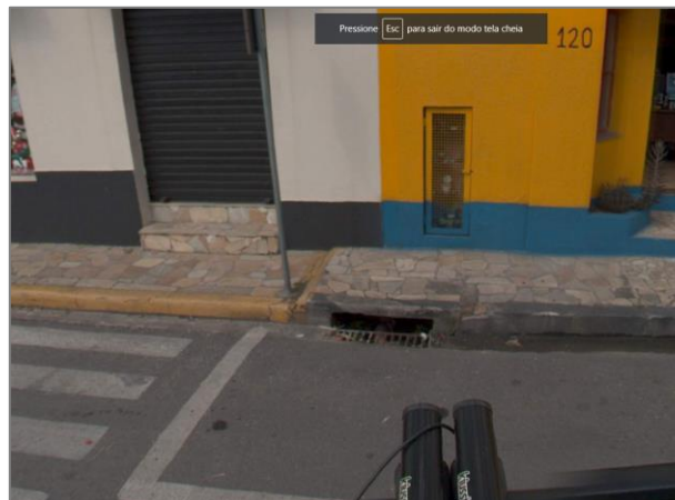
FIGURA 245 - BOCA DE LOBO NA RUA PROF. EDEGAR A. FERRAZ FONTE: GEOPIXEL 2023
