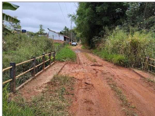
FIGURA 240 - PONTE BAIRRO BOCAINA FONTE: ACERVO DO AUTOR, 2023
