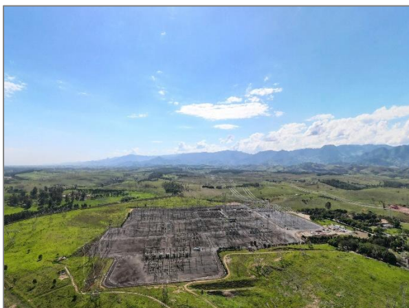
FIGURA 219 – SUBESTAÇÃO DE ENERGIA DE FURNAS FONTE: GOOGLE EARTH, 2023
