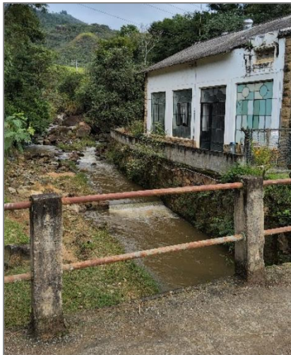
FIGURA 237 – PONTE DA USINA HIDROELÉTRICA SERRA DA BOCAINA FONTE: ACERVO DO AUTOR, 2023
