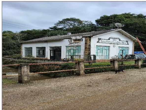
FIGURA 69 – USINA HIDROELÉTRICA FONTE: ACERVO DO AUTOR, 2023
