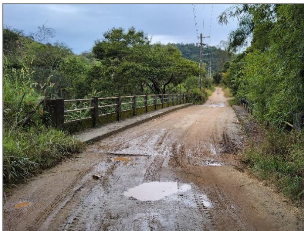
FIGURA 239 - PONTE BAIRRO BOCAINA FONTE: ACERVO DO AUTOR, 2023
