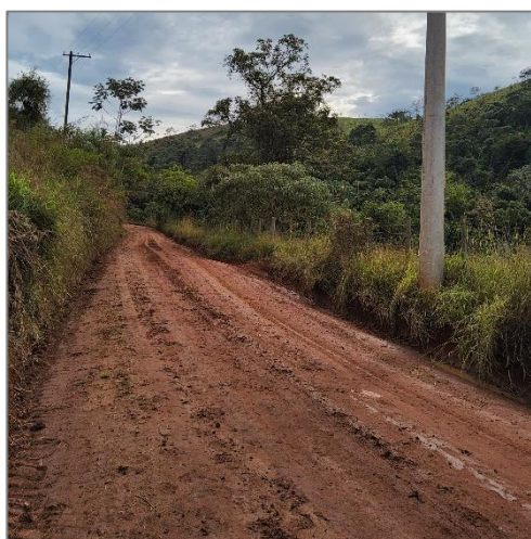
FIGURA 246 – VIA SEM PAVIMENTAÇÃO BAIRRO DA BOCAINA FONTE: ACERVO DO AUTOR, 2023
