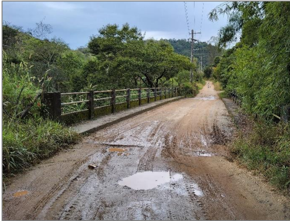
FIGURA 29 - PONTE BAIRRO BOCAINA FONTE: ACERVO DO AUTOR, 2023
