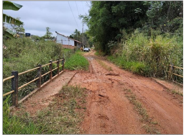
FIGURA 30 - PONTE BAIRRO BOCAINA FONTE: ACERVO DO AUTOR, 2023
