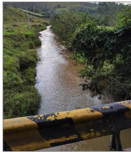
FIGURA 28 - PONTE NO BAIRRO BOCAINA FONTE: ACERVO DO AUTOR, 2023
