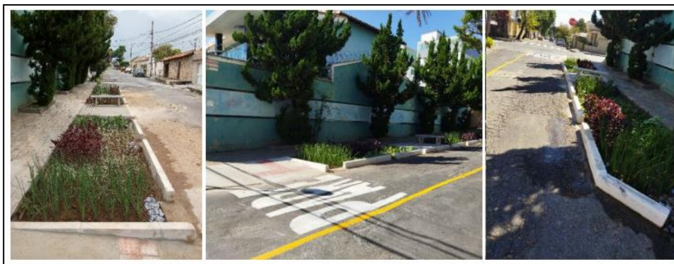
FIGURA 8 – JARDIM DE CHUVA, BELO HORIZONTE - MG. FONTE: SMOBI, BELO HORIZONTE, 2022
