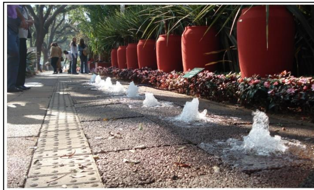
FIGURA 7 – PISO PERMEÁVEL, CASA COR BENEDITO ABBUD. FONTE: ASSOCIAÇÃO BRASILEIRA DE CIMENTO PORTLAND - ABCP, 2021
